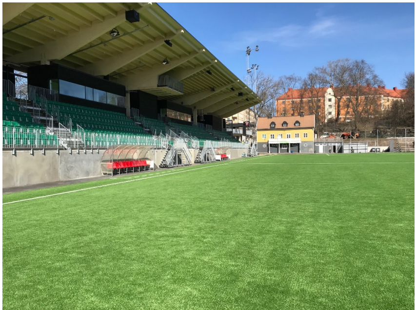
Färdig anläggning våren 2018, Hammarby Fotbolls klubbstuga i bakgrunden.
