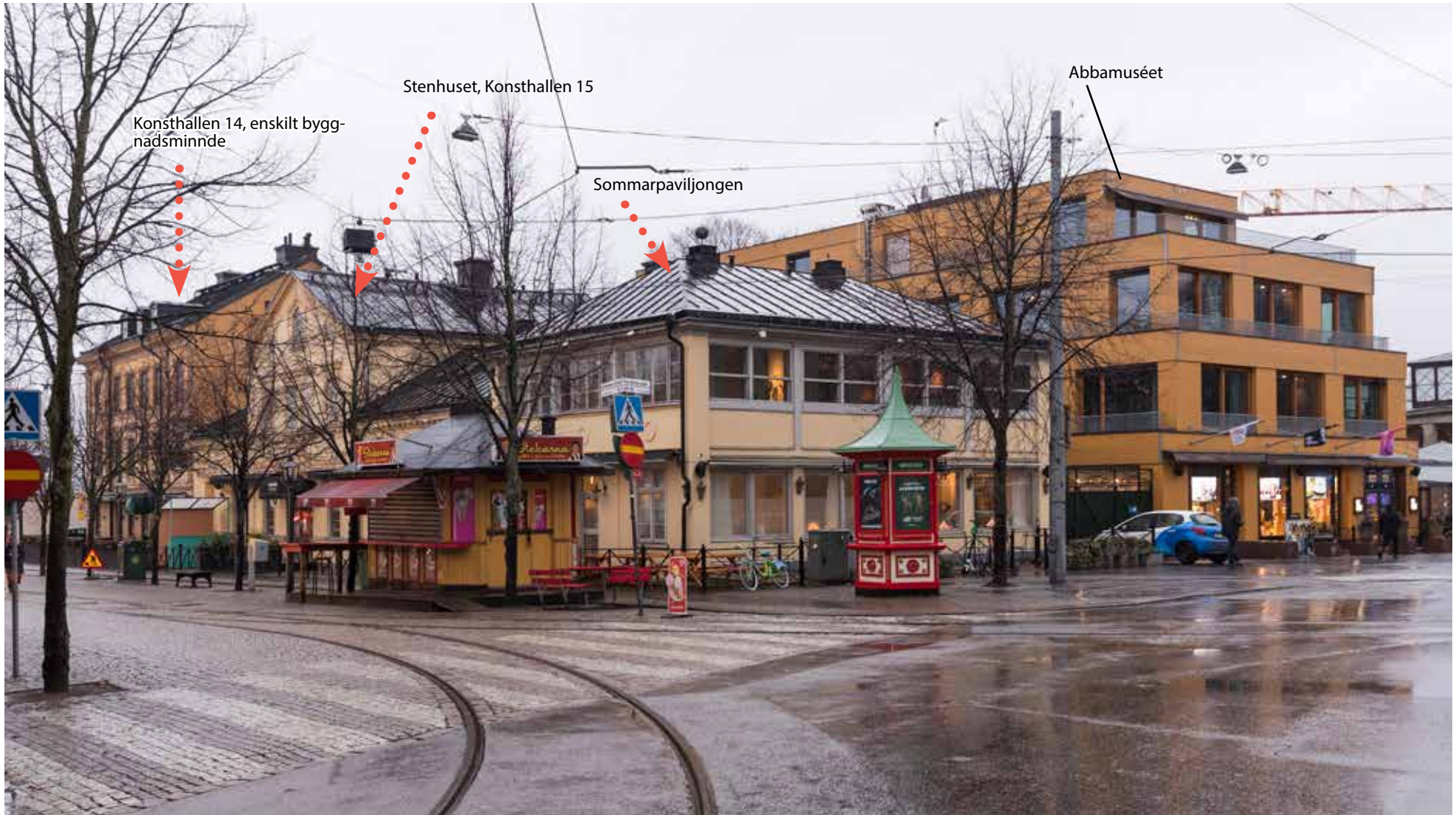
Bild som visar de aktuella byggnaderna med tillbyggnaden från 20-talet till höger och huvudbyggnaden till vänster. Foto Stockholms stad, december 2018.
