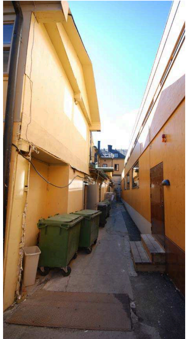
Till vänster byggnadens norra fasad mot gränden.
