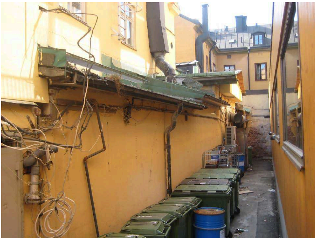
Del av fasadsträckan mot gränden i norr där den tidigare byggnaden på nuvarande grannfastigheten anslöt.
