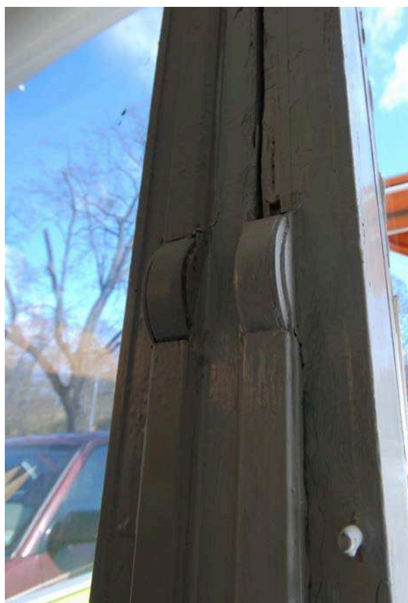
Fotografier från tillbyggnadens bottenvåning.
