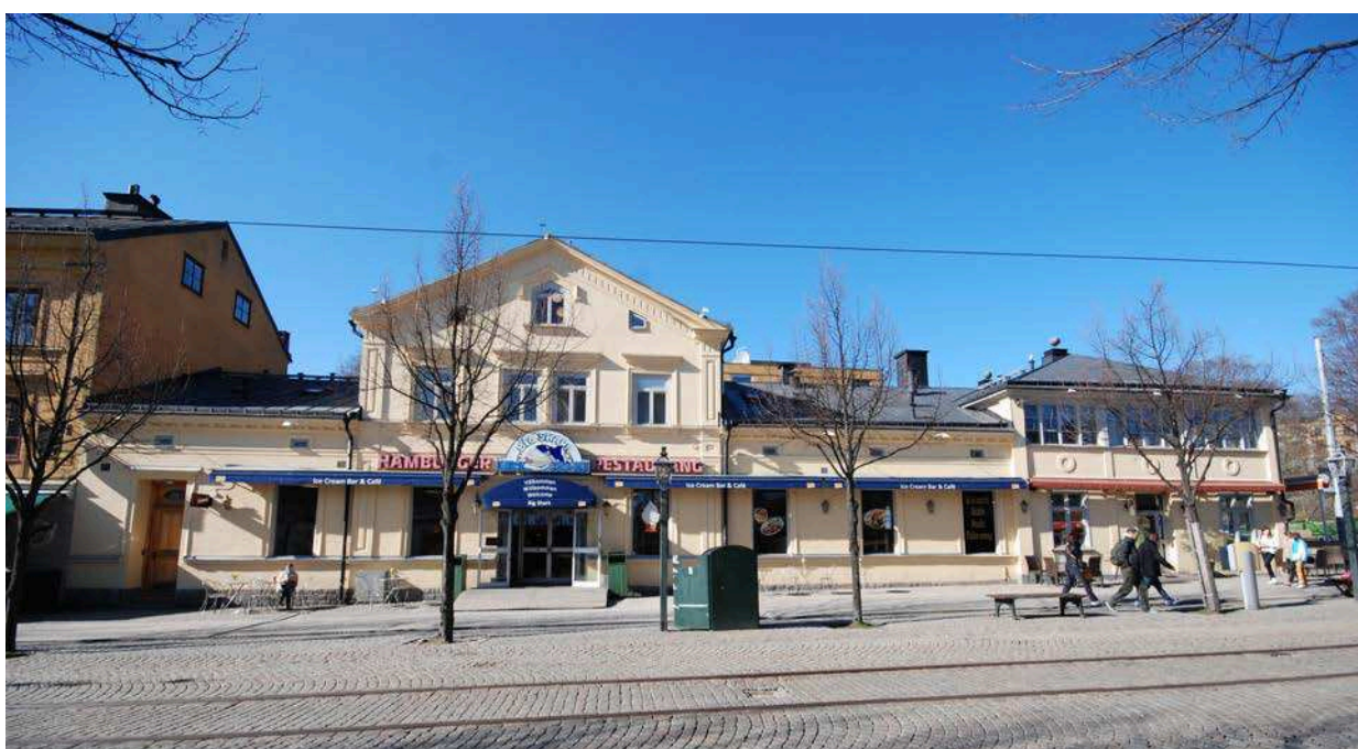
Ovan tillbyggnadens fönster mot Allmänna gränd. Nedan byggnadens fasad mot Allmänna gränd. Till vänster huvudbyggnaden från 1880-talet, till höger 1920-talets tillbyggnad. Foto mot norr.
