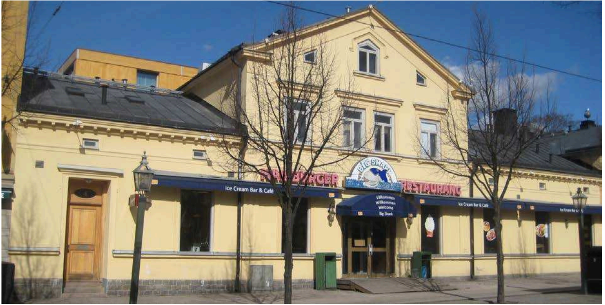
Huvudbyggnadens fasad mot gatan. Till vänster kontorsentrén med port av eksnickeri och i mitten glasade aluminiumpartier vid restaurangentrén. Fönstersnickeri av instickstyp i de övre våningarna och hela ospröjsade rutor i gatuplanet. Sammanhängande fasadmarkiser längs nästan hela fasadsträckan.
