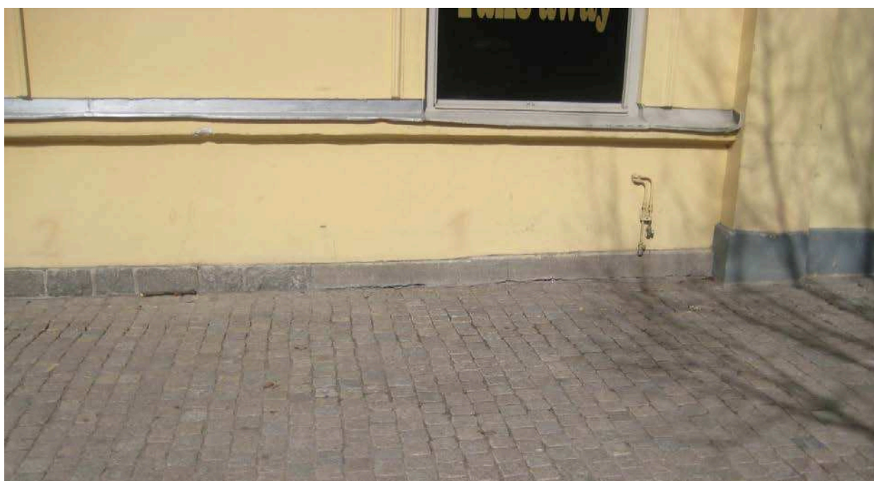
Olika typer av sockelmateriäl mot Allmänna gränd. T.v. naturstensblock, i mitten slätputs med ritsad kvaderindelning och t.h. målad betongsockel.
