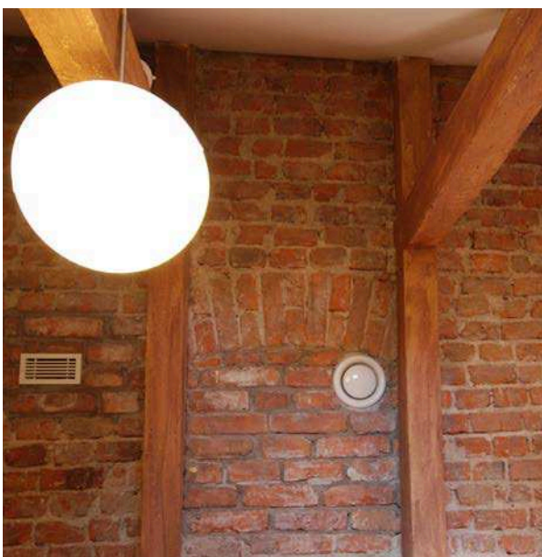
Frilagd tegelmur på våning 1 tr. med spår av ursprunglig, igenmurad öppning mot norr.
