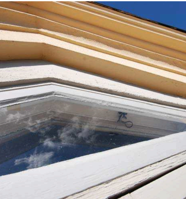
Överst fasaddetalj huvudbygganden. Därunder tillbyggnadens fasad mot gränden i norr. Underst frontespisens fönster med kraftig, putsad instickskarm.
