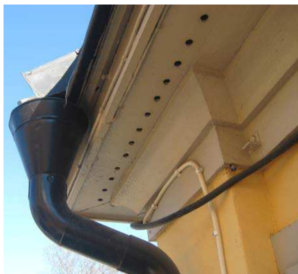
Luftningshål i tillbyggnadens takfotsinklädnad. Troligen tillkomna i sen tid.
