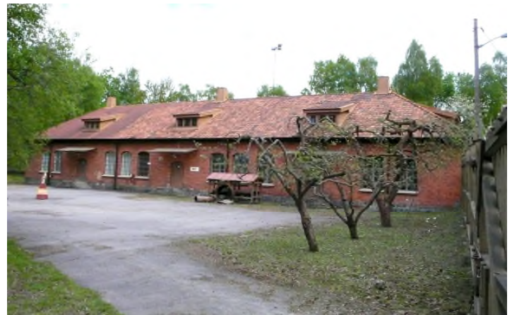
Befintlig byggnad entrésida
