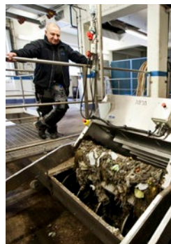
Gallerrens, det vill säga skräp som spolats ner i toaletten, samlas in och går till energiutvinning.
