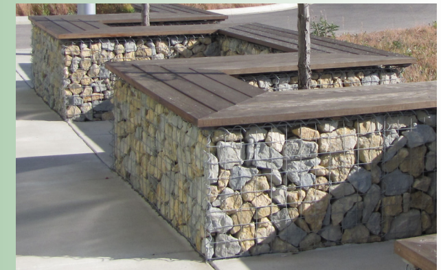
Inspiration LOD - mur av gabioner
