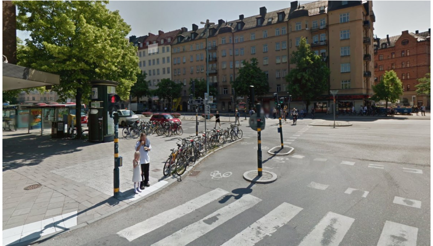
Figur 4. Gång och cykelöverfart över Fridhemsgatan före ombyggnaden
