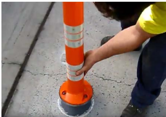
Figur 11 Fastlimning av pollare i vägbana.
