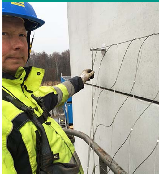
Installation av växtvajer. Bild : C/O City
