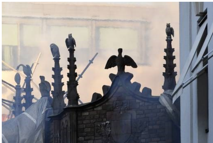
Gatufasaden är till största delen bevarad. Bilden visar de i huvudsak kvarstående fialerna på hushörnets krön.
