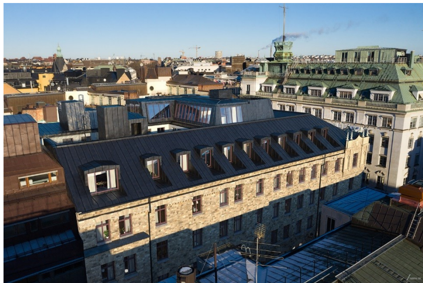
Vy mot öst, taket utförs i plåt i en mörk kulör för att ansluta till Stockholms traditionella taklandskap.
