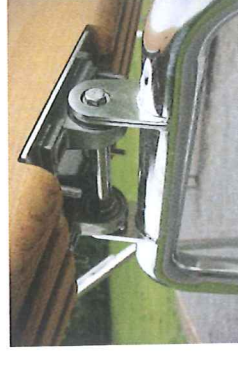
17. Stål används i underreden till möbler. Obehandlat, rostfritt stål används i kombination med lackat stål.
