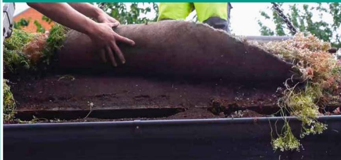
Bra form för ljuddämpning av grönt platt tak med låg skärm vid kant Grönatakhandboken Bild: Jonathan Malmberg Scandinavian Green Roof Institute
