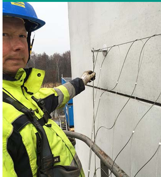
Installation av växtvajer. Bild : C/O City
