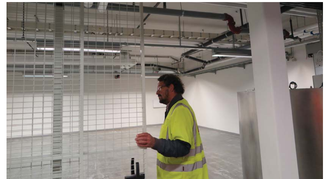
LAGERVÄGG MED SKJUTDÖRR -NORSBORGSDEPÅN
