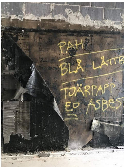
Uppmärkt vägg i byggnad som ska rivas.
