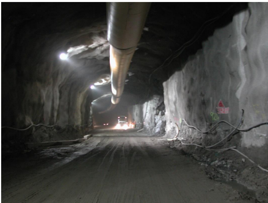
Figur 2 Bild över en typisk arbetstunnel för dubbelrörsprojekt innan genombrott (Ingason et al., 2010).
