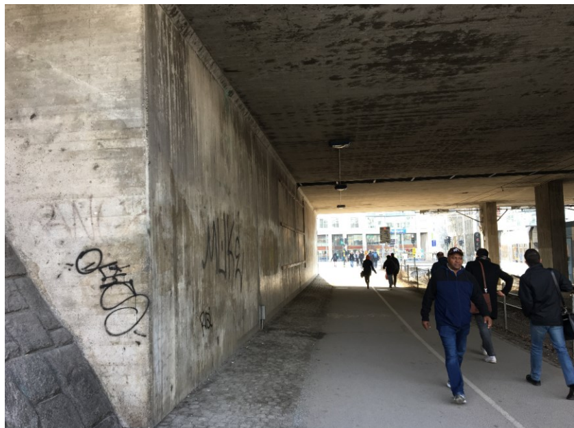
Figur 4. Befintlig gångtunnel mellan Marievik och Liljeholmen där åtgärder planeras för att öka trygghet och trivsel för gående.
