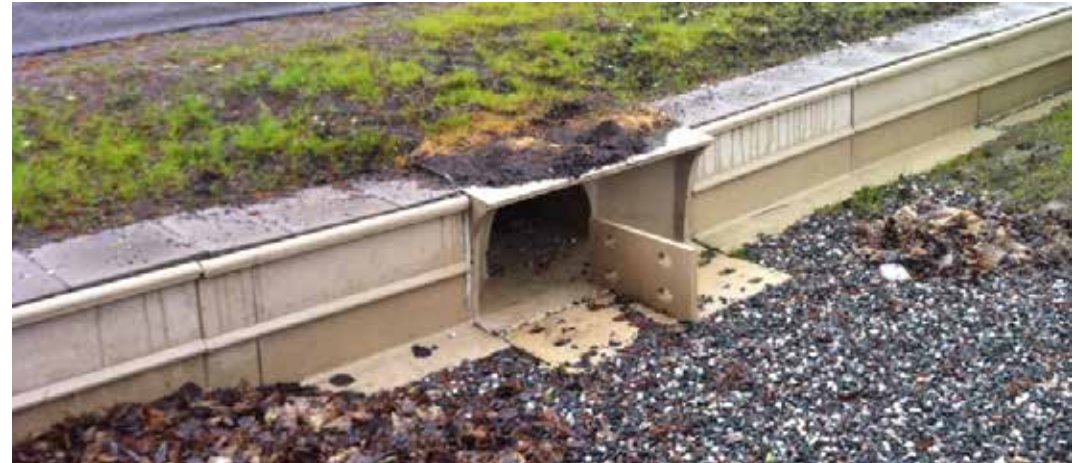
Figur 28. Groddjurstunnel vid Spångavägen Foto: Stockholms stad
