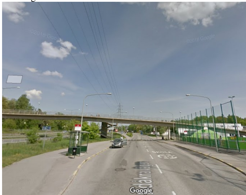
Figur 9. Sandåkravägen i riktning österut. Gångbro över Tyresövägen och Sandåkravägen med trappan mot gångbanan. Hållplatsen ska utgå. Bollplan finns på södra sidan.
