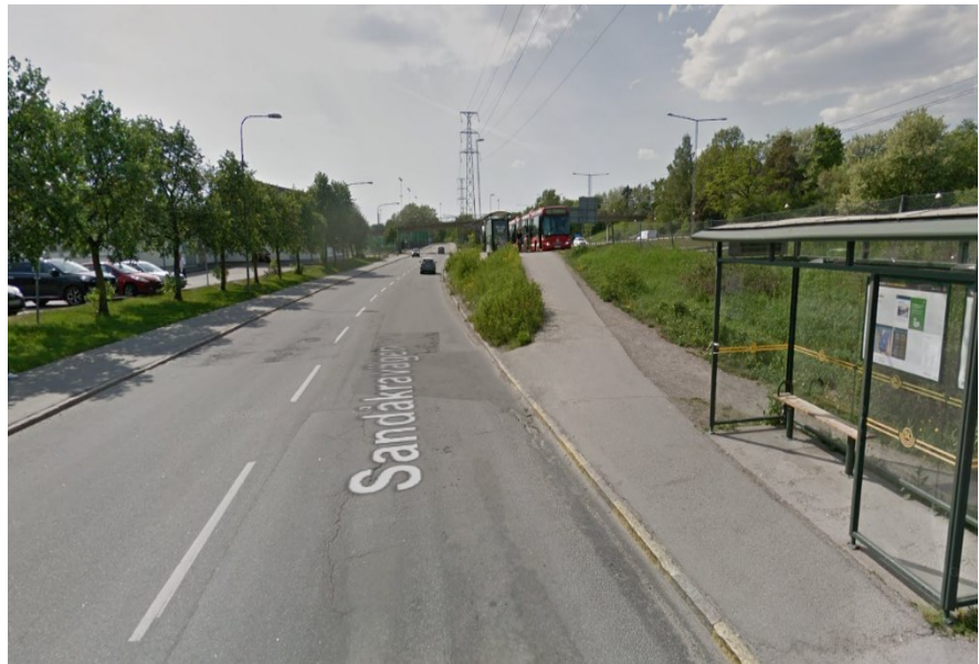
Figur 7. Hållplatsen på norra sidan av Sandåkravägen och rampen mot hållplatser på Tyresövägen
