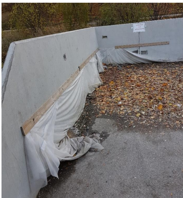
Figur 7. Exempel på vallar och fiberduk vid plats för snöupplag, från Boovallen i Nacka kommun.
