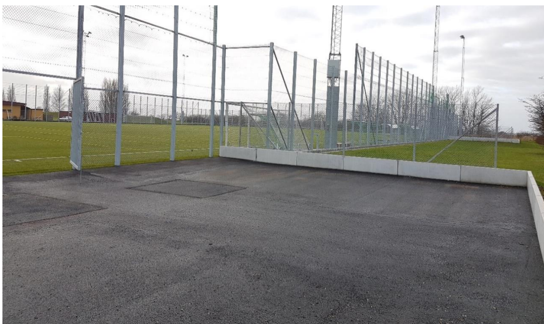
Figur 14. Exempel på asfalterad plats avsedd för snöupplag. Bunkeflo IP, Malmö.
