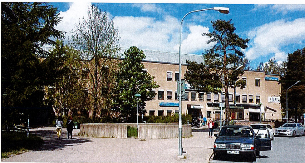
Befintlig byggnad inom planområdet sett från söder
