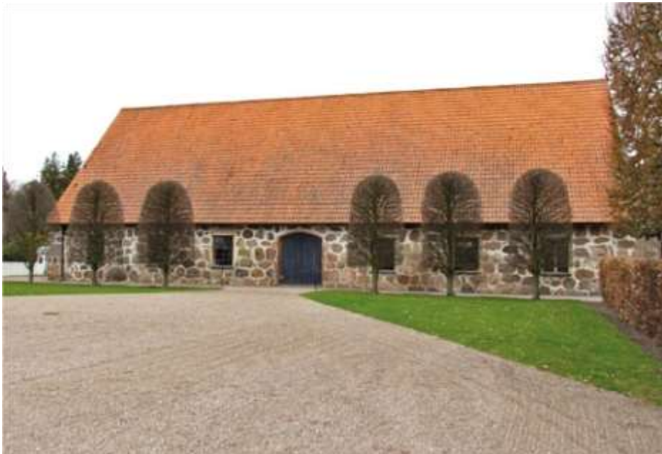
Symmetriska planteringar med formbeskurna träd kan vara en viktig del av den arkitektoniska gestaltningen och det kulturhistoriska uttrycket. Här kan död ved och olikåldrighet upplevas som störande. Krapperups slott, Skåne län. Foto: Fabian Mebus.
