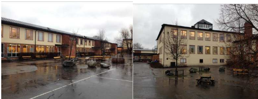
Vällingbyskolan, Hus A
