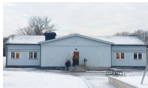
Hus F. Paviljong som skall rivas.
