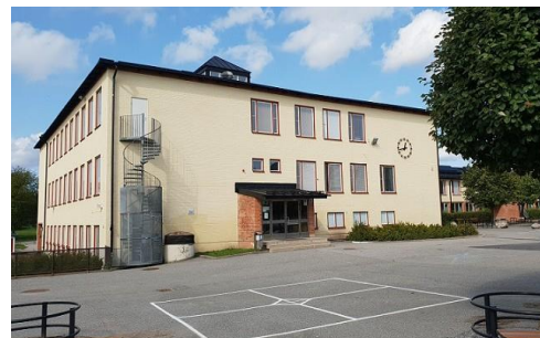
Hus A högdal med lanternin och huvudentré mot skolgården sedd från söder.
