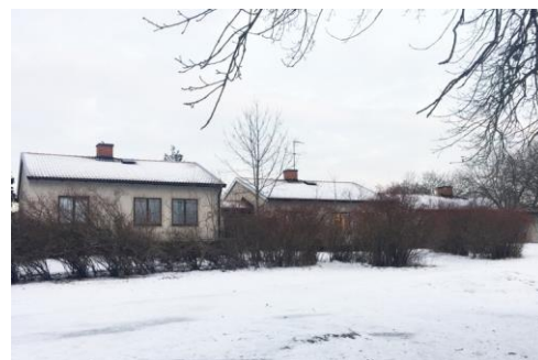
Hus C. F d lärarbostad.
