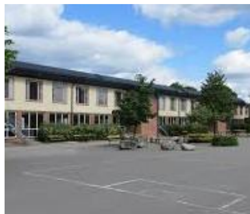
Skolgården. Del av skolgården mot hus A. Skolgården har upprustats i ett sk "skolgårdsprojekt".
