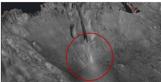
Figur 10. Detaljbild över dagvattenledning i nordöstra Riddarfjärden, se figur 8. Röd ring markerar mynningen på ledningen framför vilken erosion och avvikande sedimenthårdhet framträder.
