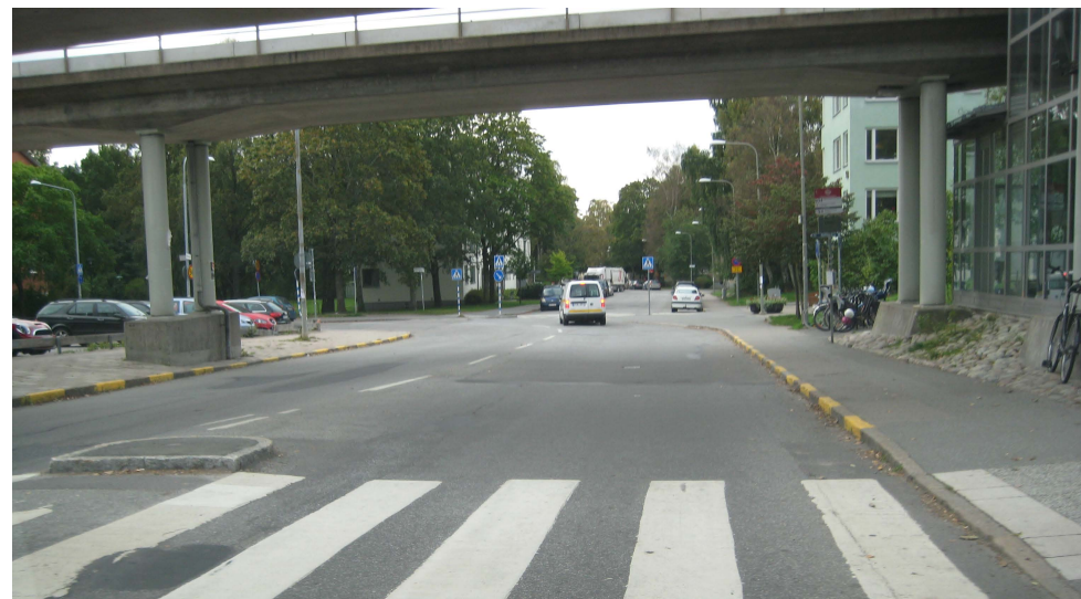
Ulricehamnsvägen vid Finn Malmgrens väg, riktning söderut.
