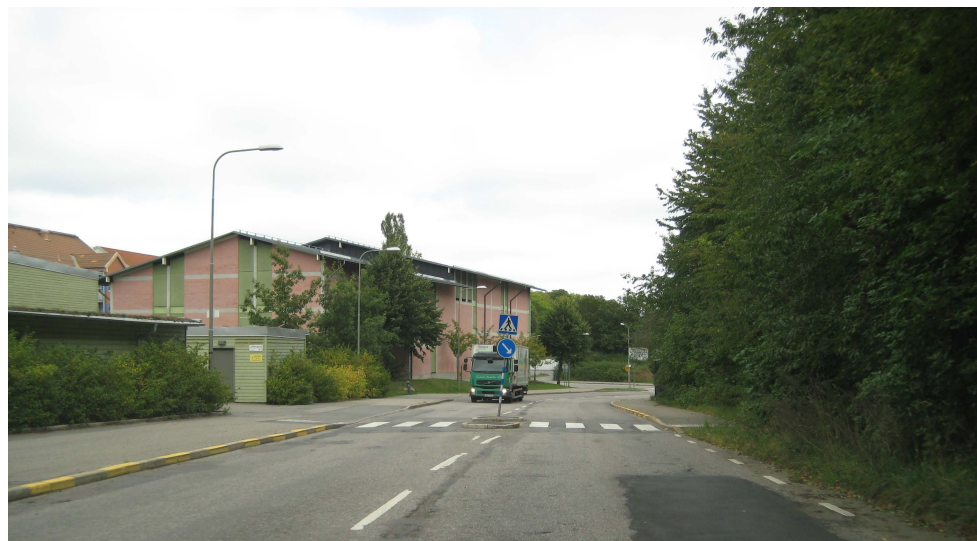
Flygfältsgatan vid Tåtorpsvägen, riktning österut.
