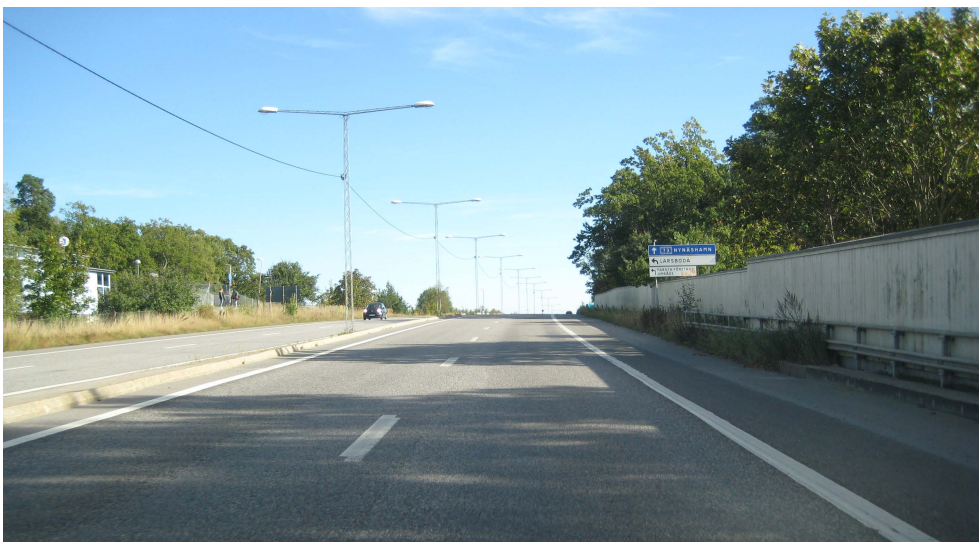
Magelungsvägen vid Ullerudsbacken, riktning österut.
