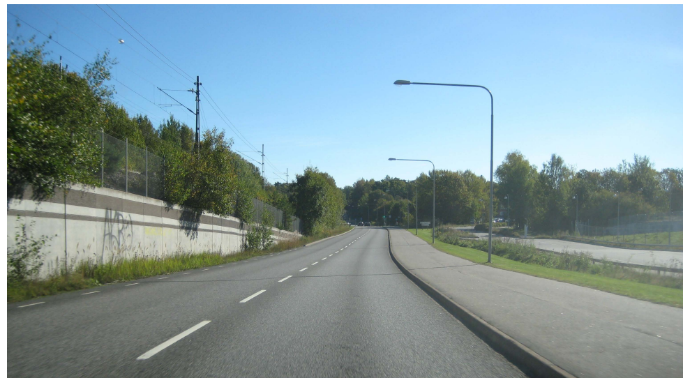
Magelungsvägen vid Farstaängsvägen, riktning österut.
