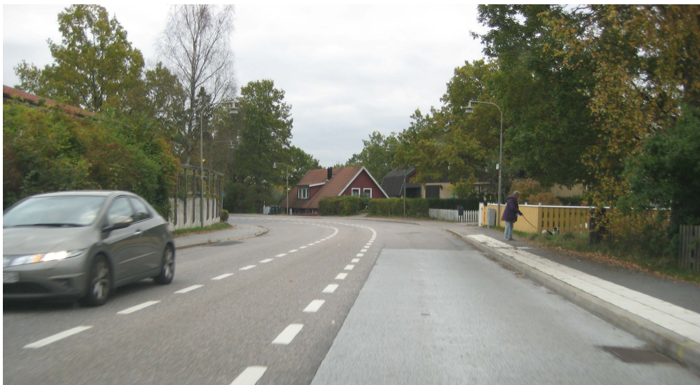
Havsörnsvägen vid Ejdervägen, riktning söderut.
