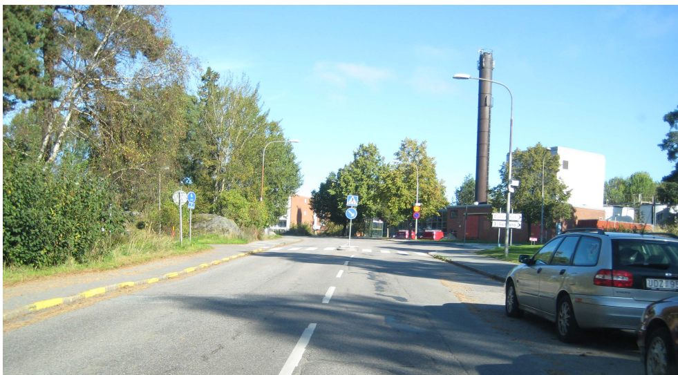
Stångåvägen vid Ljusnevägen, riktning norrut.
