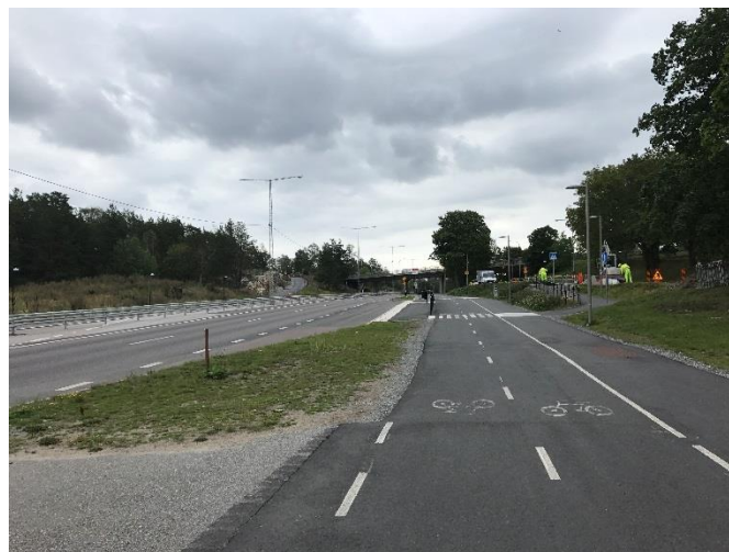
Bild 3. Löfstavägen efter ombyggnaden. Sedd från Krossgatan.
