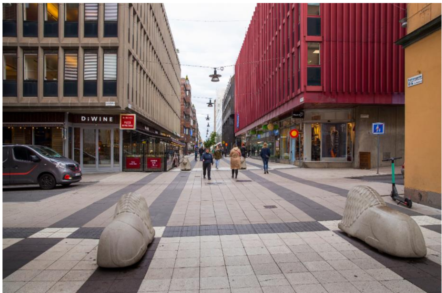
Figur 16. Drottninggatan vid Herkulesgatan efter ombyggnad
