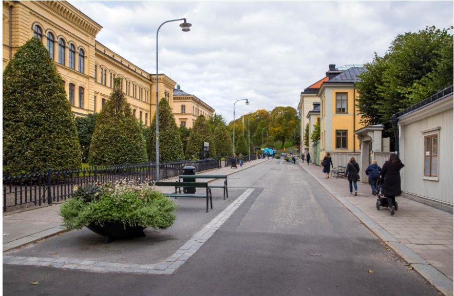
Figur 6. Drottninggatans norrut från Rådmansgatan efter ombyggnad med ny möblering som är i tidigare körbana.
