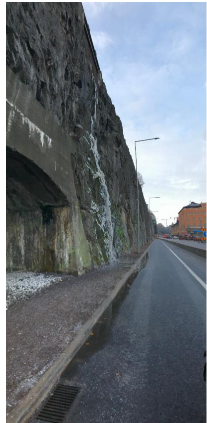
Figur 3. Det nyanlagda körfältet.
