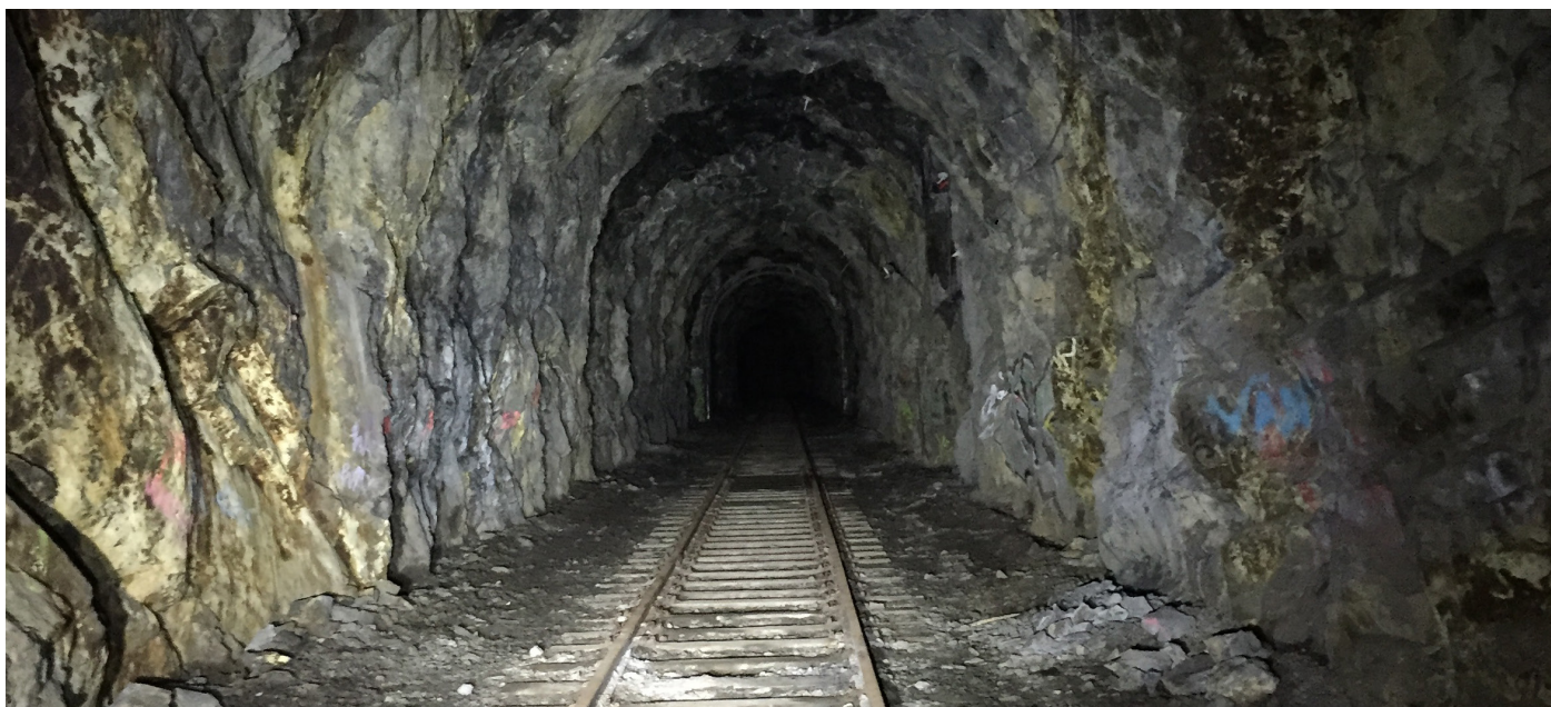
Cirka 200 meter in i tunneln västerifrån
