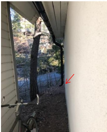
Figur 6. Stuprör från garaget som mynnar ovan mark för infiltration i fyllnadsmassor, röd pil (Foto Magnus Rydstedt)
