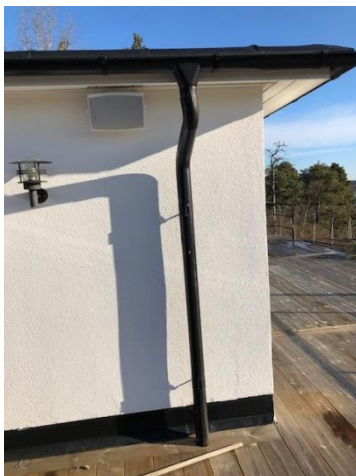
Figur 4 Stuprör från huvudbyggnaden som leds till markområde (Foto Magnus Rydstedt)
