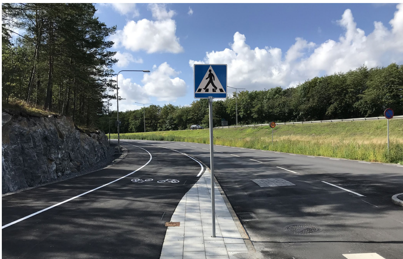
Flatenvägen efter ombyggnad.
