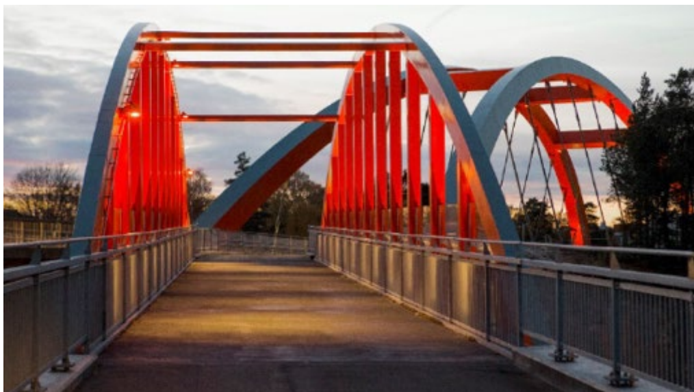
Ny gång- och cykelbro över Åbyvägen.
