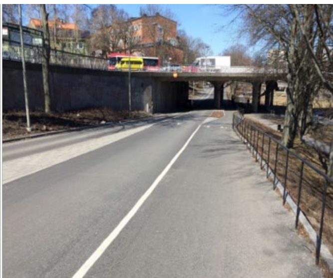
Västerbronedfarten norr om det norra övergångsstället innan och efter ombyggnad.
