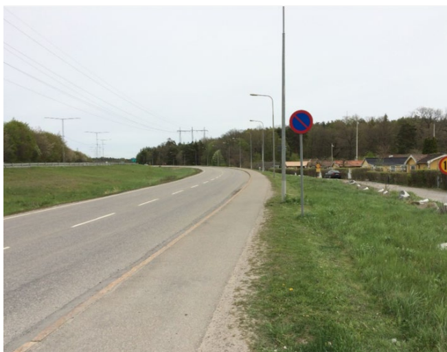
Flatenvägen innan ombyggnad.
