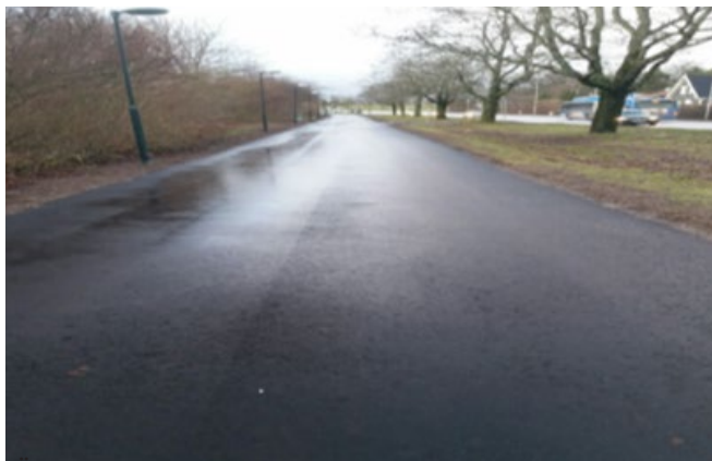
Alvsjövägen efter åtgärd.
