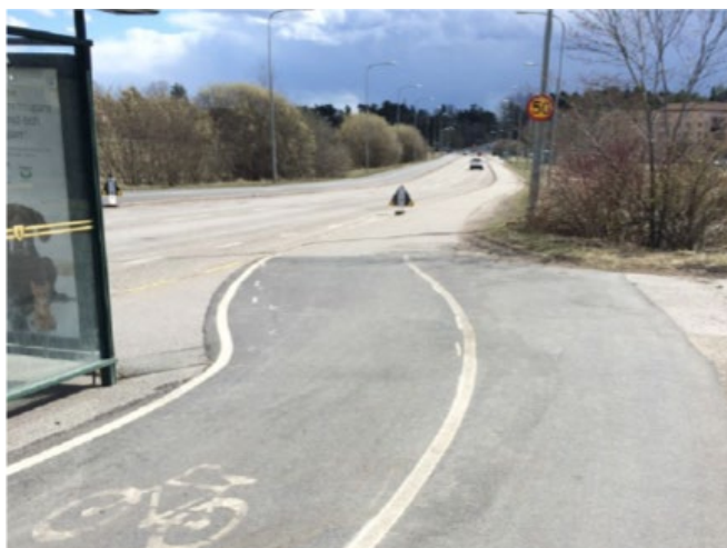
Spångavägen innan ombyggnad.
