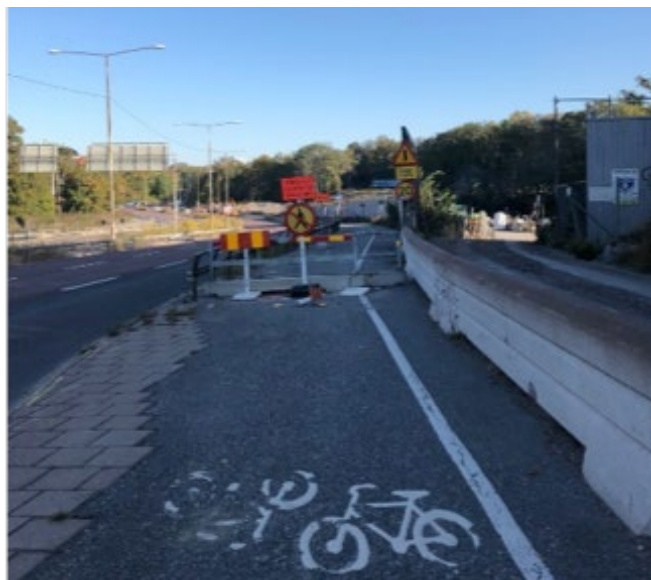
Roslagsvägen norrut vid pågående utbyggnad av Albano
