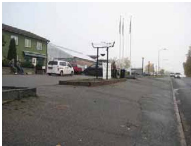
Innan ombyggnad. Kraftig lutning och flera utfarter vid Tornväktargränd.
