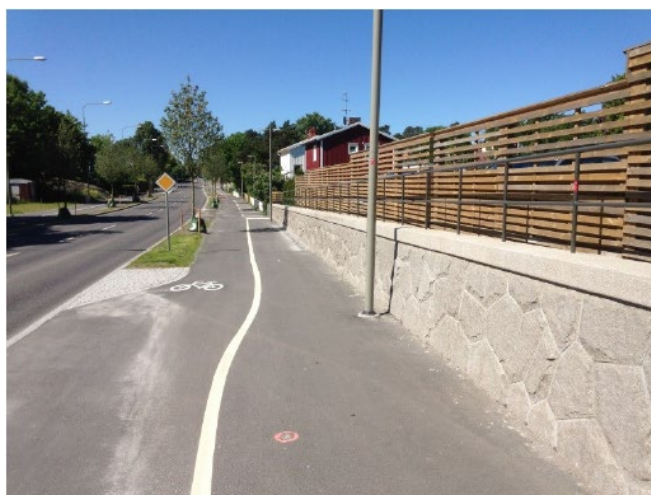
Gångbana vid Tornväktargränd efter ombyggnation.
