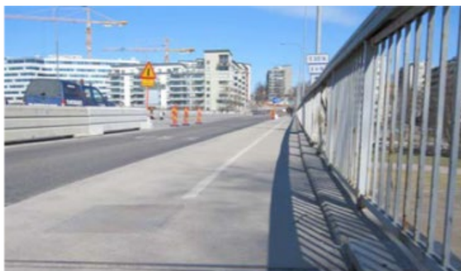
Lilla Västerbrons gång- och cykelbana innan ombyggnad.
