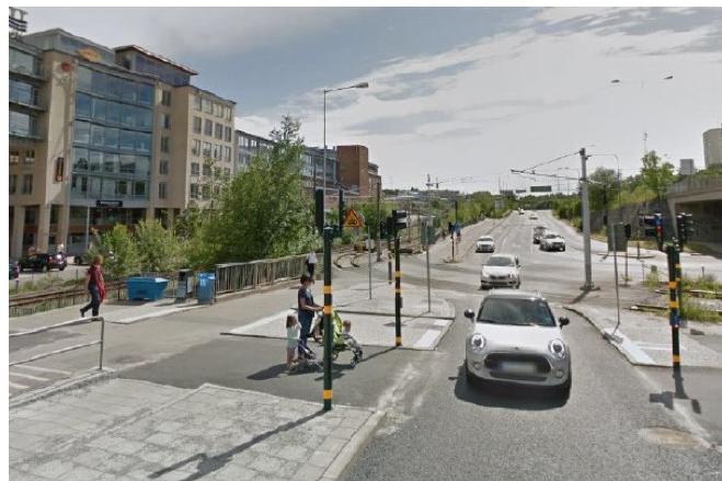
Södertäljevägens påfartsramp med utökade väntytor efter ombyggnad.
