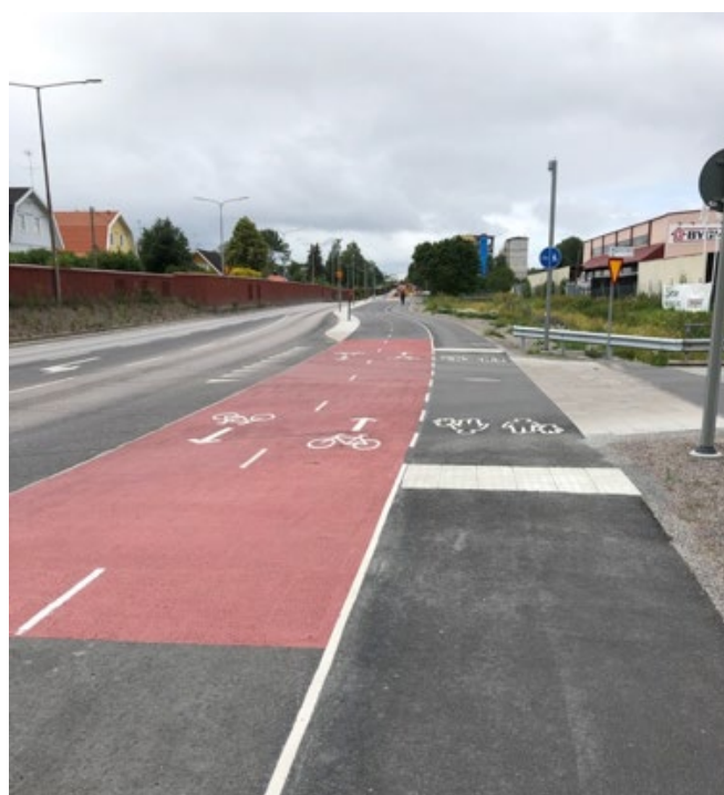
Färdigställda delar av projektet i juni 2019.
