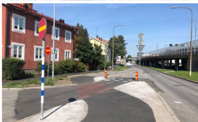
Cykelpassage vid Tallkrogsvägen efter ombyggnad.
