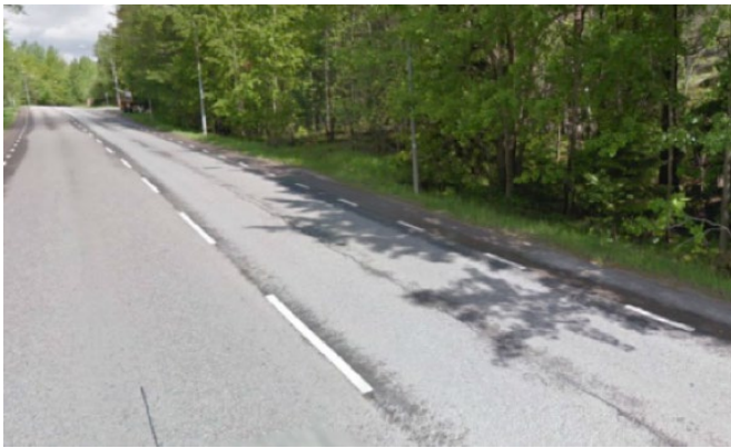
Ältabergsvägen före och efter ombyggnad.
