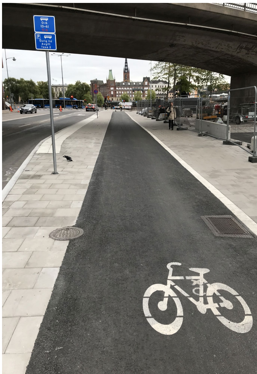
Färdigställd cykelbana mellan Centralstationen och Tegelbacken.
