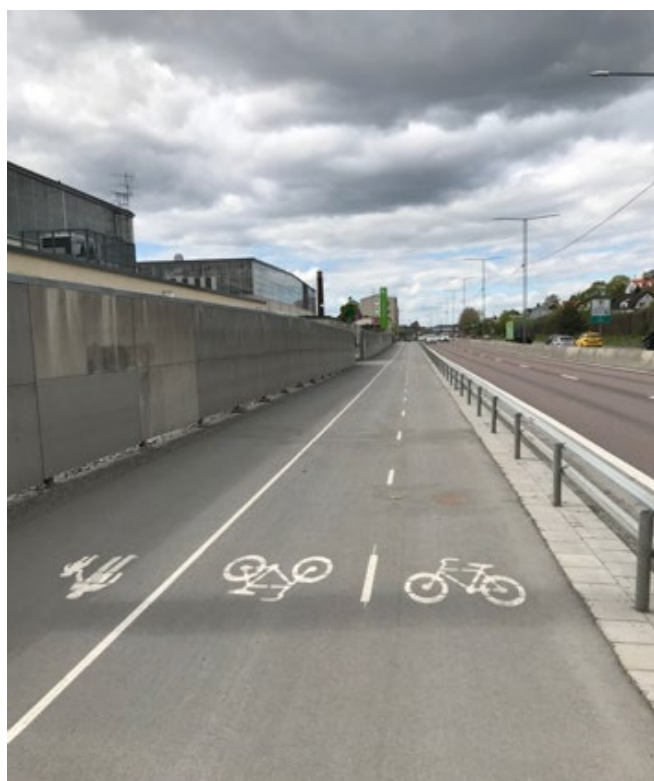
Färdigställd sträcka förbi Bromma Blocks.
