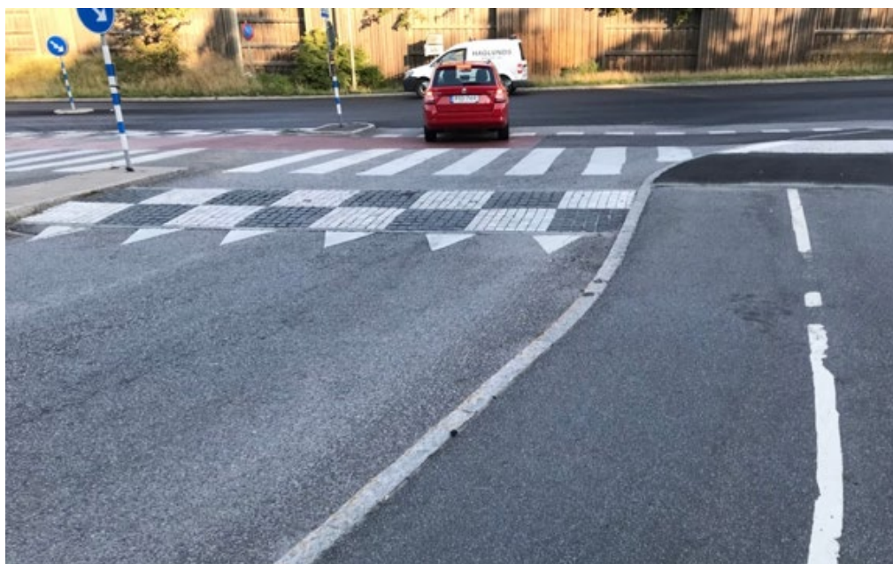
Ny hastighetssäkrad cykelpassage över Folkparksvägen.
