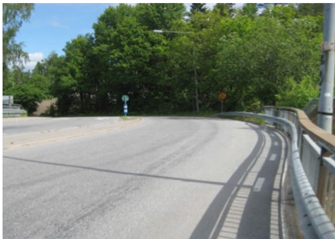
Perstorpsvägens viadukt över järnvägsspåren före respektive efter ombyggnad.
