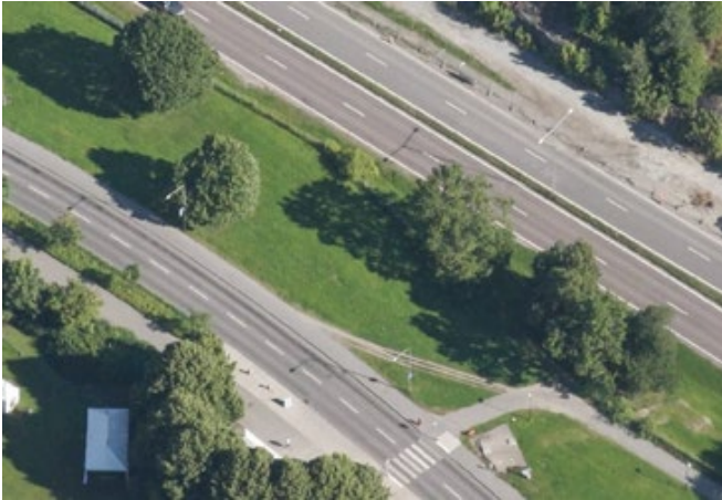
Saknad länk mellan Krossgatan - Bergslagsplan, innan ombyggnad.
