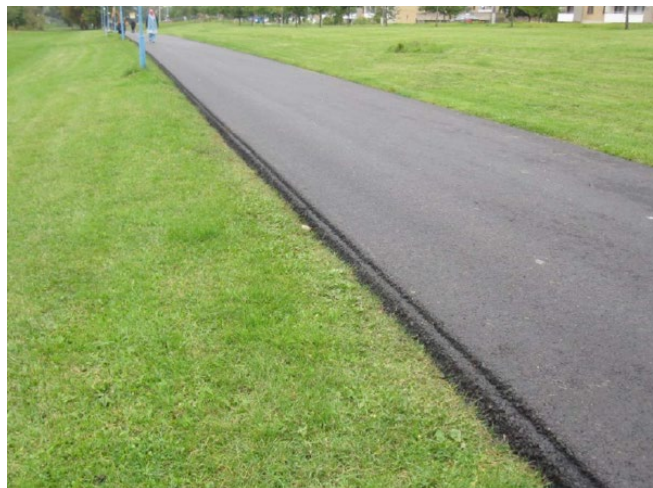
Ny beläggning på Tensta-Rinkebystråket.
