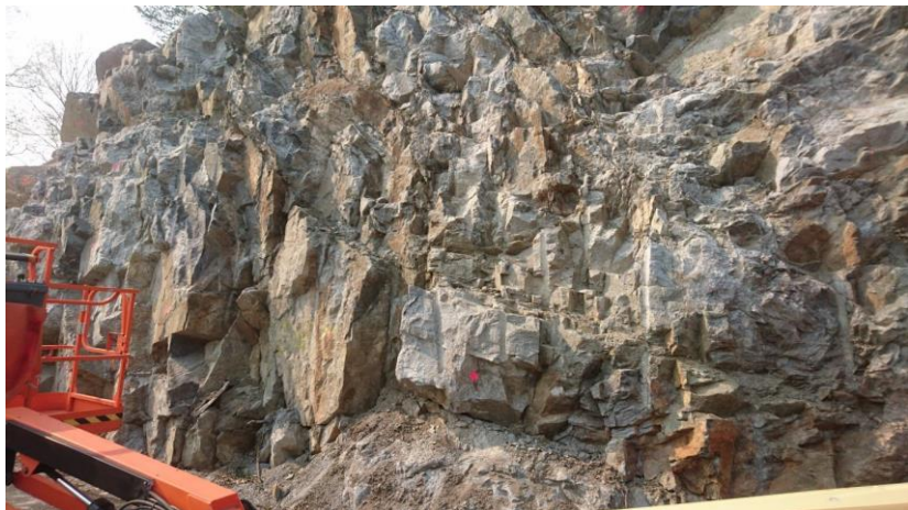
Bild 5. Bergsslanten efter utförd spräckning.
