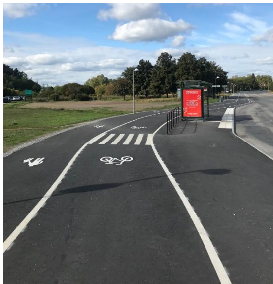
Bild 7. Ny gång- och cykelbana samt ombyggd busshållplats vid Sundbyvägen.
