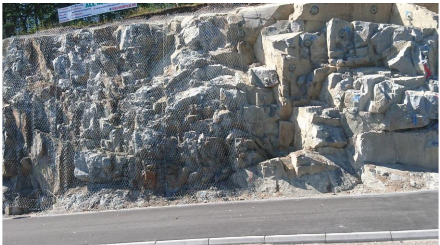
Bild 6. Bergsförstärkning med bultar samt skyddsnät.
