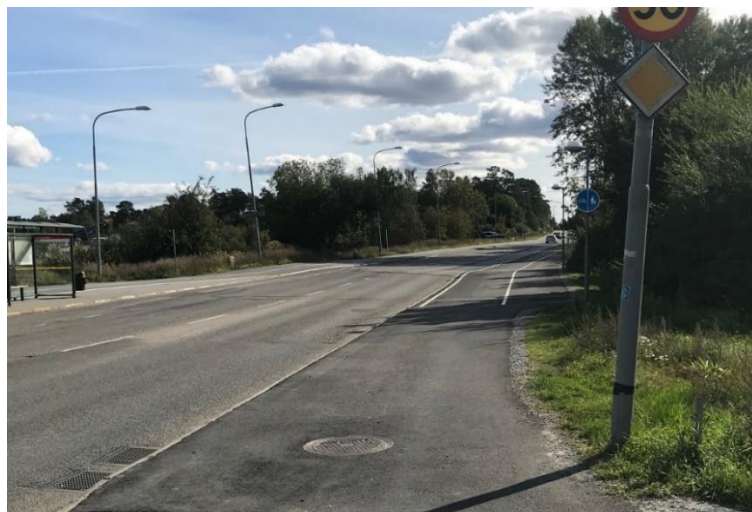
Bild 9. Sträcka där breddning ännu inte kunnat genomföras på grund av högspänningsledning.
