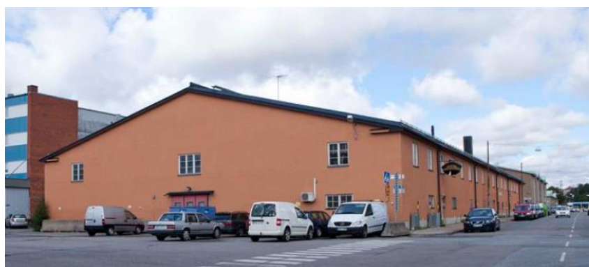
Byggnad 43. Magasinsbyggnaden från 1936, väster om Hallvägen.
