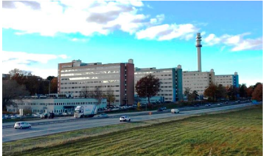
Skivhusen och teletornet i Vitsand utgör ett markant landmärke med sin placering i dalstråket längs Nynäsvägen. Fotot är hämtat ur samrådshandlingarna.
