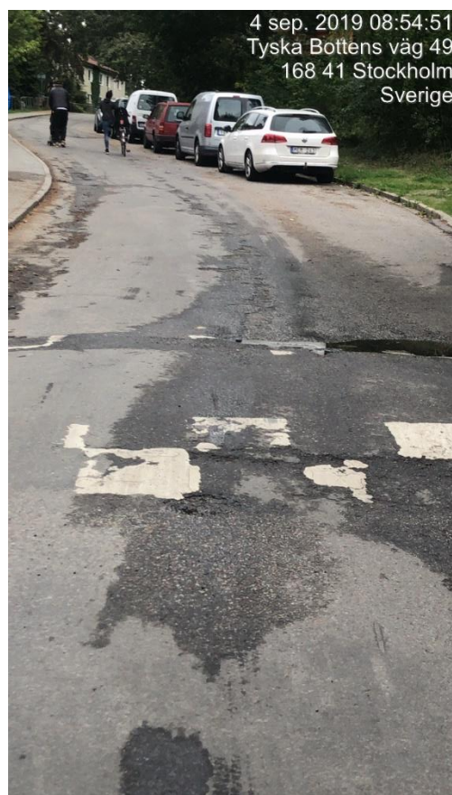
Figur 1. Potthål och sprickbildningar
