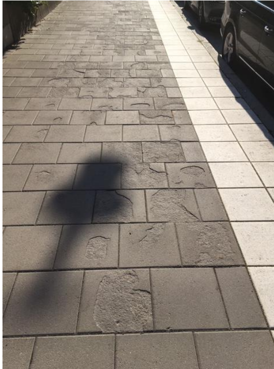
Figur 5. Trasiga gångbaneplattor
