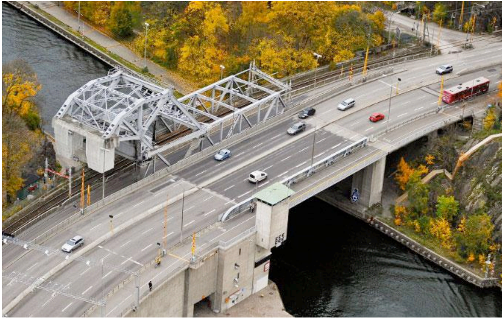
Figur 5. Flygfoto som visar befintligt bro i väst-östlig riktning (källa: eniro.se).
