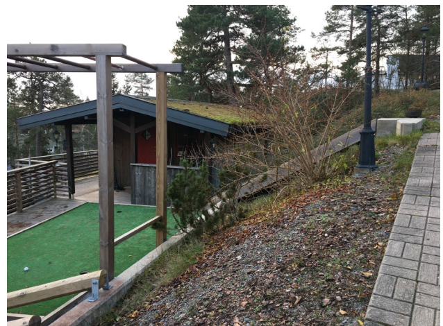
Befintlig komplementbyggnad med vy från nordväst. Komplementbyggnaden ska rivs till förmån för en ny huvudbyggnad på samma plats.
