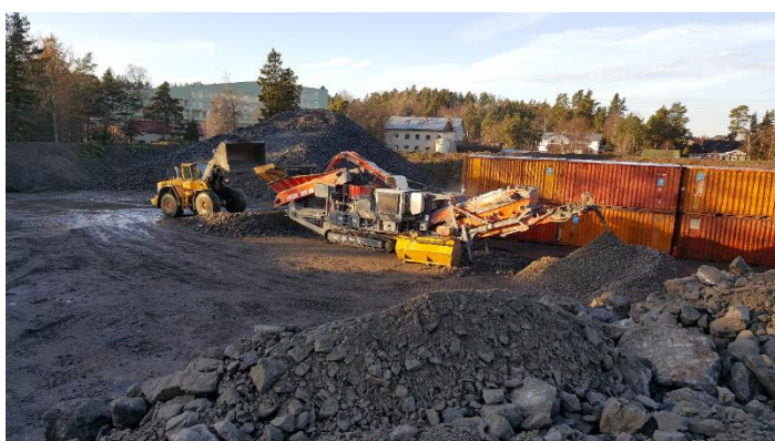
Foto: Krossmaskin och hjullastare bakom bullerskyddande containrar
