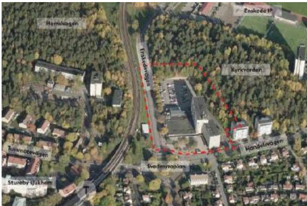
Flygbild över området. Det inkomna planförslagets ungefärliga läge är grovt markerat med en röd streckad linje.
