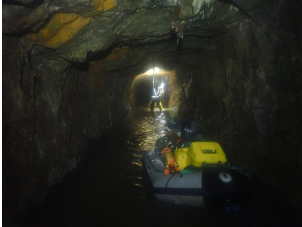
Figur 3. Bild från inmätning av tunneln i aktuellt område.
