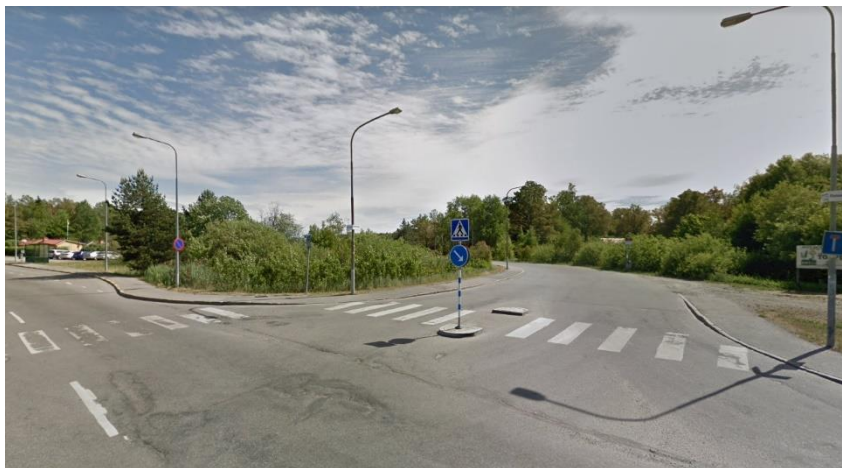
Figur 3. Korsning och hållplatsläge före ombyggnad.
