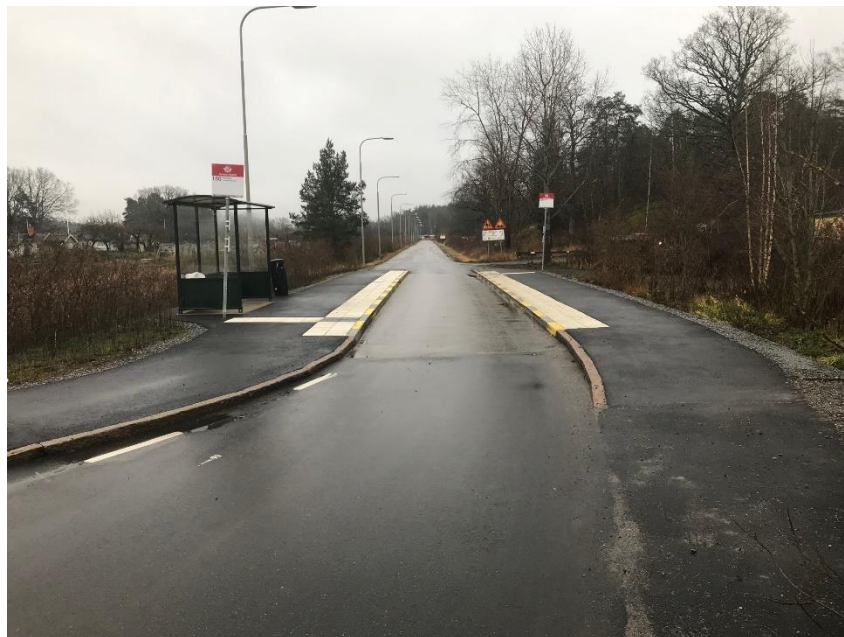
Figur 5. Hållplats i nytt läge efter ombyggnad.
