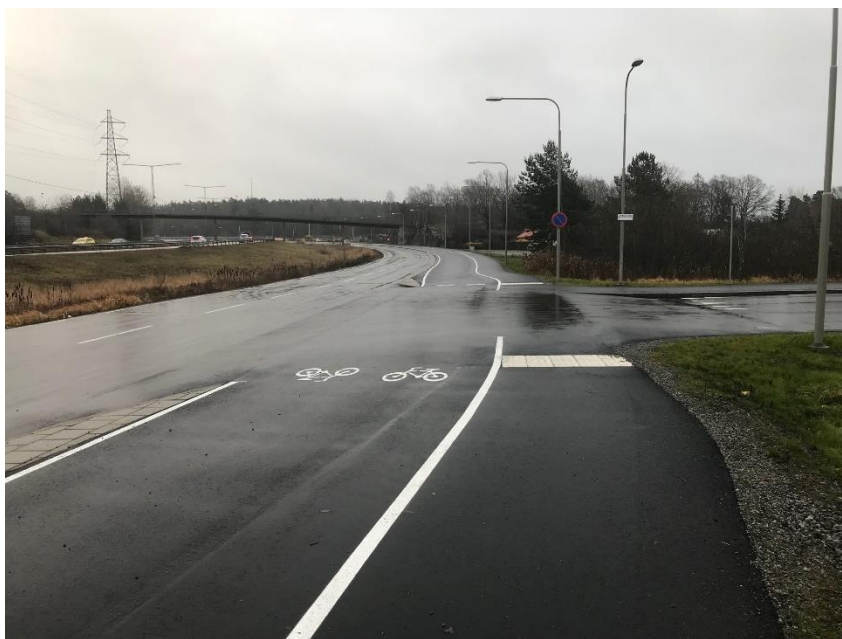
Figur 4. Korsning efter ombyggnad.
