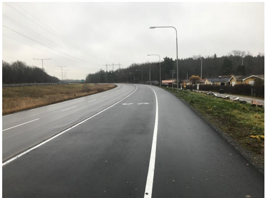
Figur 2. Gång- och cykelbanan efter ombyggnad
