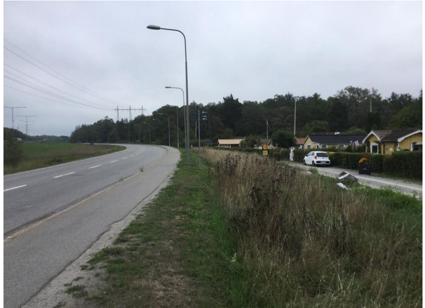
Figur 1. Gångbanan innan ombyggnad
