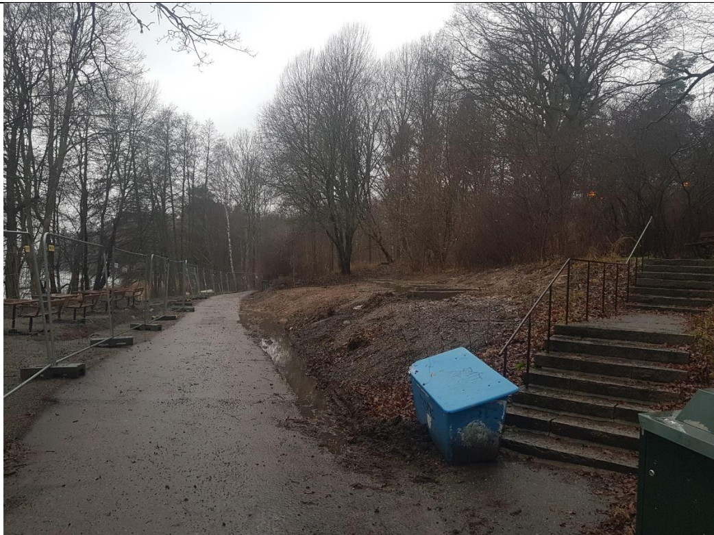
Röjt och gallrat, 2 st belysningsstolpar på väg.
