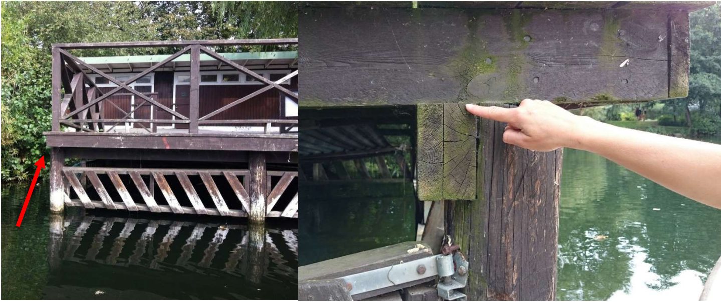
Trekanten: vattenståndet mättes in mot kant på brygga. Bilderna är från inventeringen 2014 och vattenståndet var 12 cm lägre vid årets inventering.
