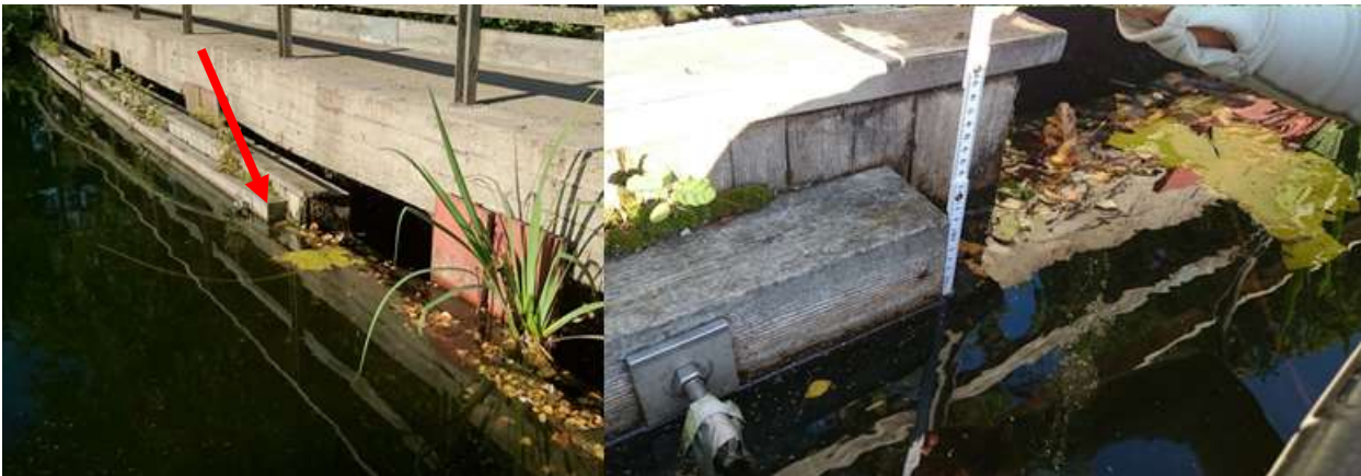
Långsjön: vattenståndet mättes in mot balk vid damm vid utloppet. Bilderna är från inventeringen 2014 och vattenståndet var på samma nivå (-8,5 cm) vid årets inventering.
