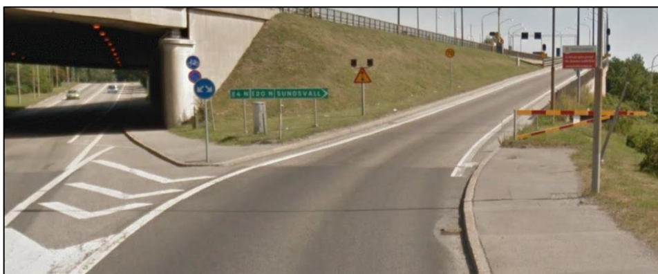
Figur 2, avsaknad passage över Nybodapåfarten.
