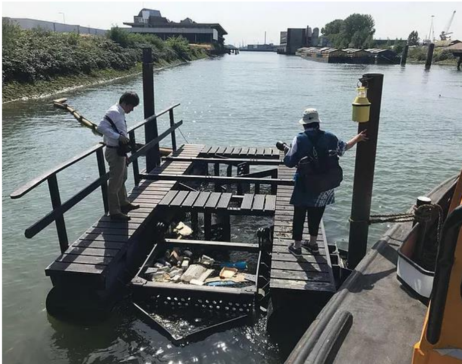
Figur 10 En av tre Litter Traps från Recycled Island Foundation i Rotterdam, Nederländerna. (Bildkälla: Recycled Island Foundation, 2019).
