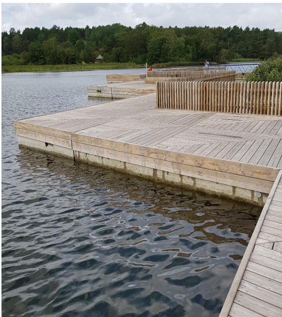
Figur 21 Gång- och solbrygga vid Farsta strandbad (Bildkälla: Sara Friberg, 2019)
