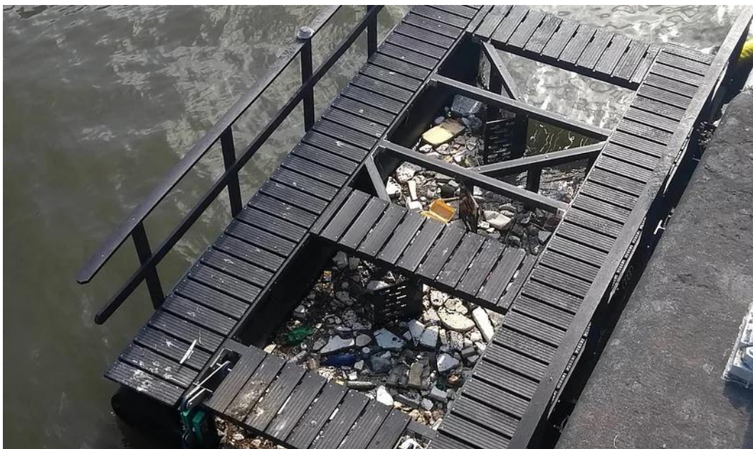
Figur 11 Litter Trap installerad i Bryssel, Belgien. (Bildkälla: Recycled Island Foundation, 2019).
