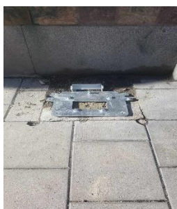
Bild 3: Det gamla stativet utgör en form som fylls med betong. Ett gods för montering av de nya klimatsmarta automaterna sänks ner, anpassas till gångbanans höjd och gjuts fast.
