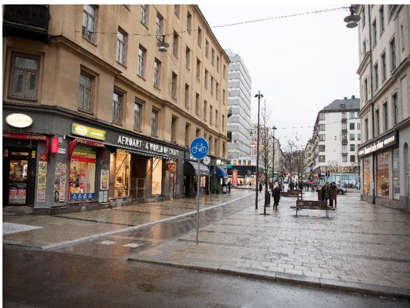
Figur 5. Norrtullsgatan efter ombyggnad, en torgyta med ny belysning, nya träd, sittmöbler och genomgående cykelbana.
