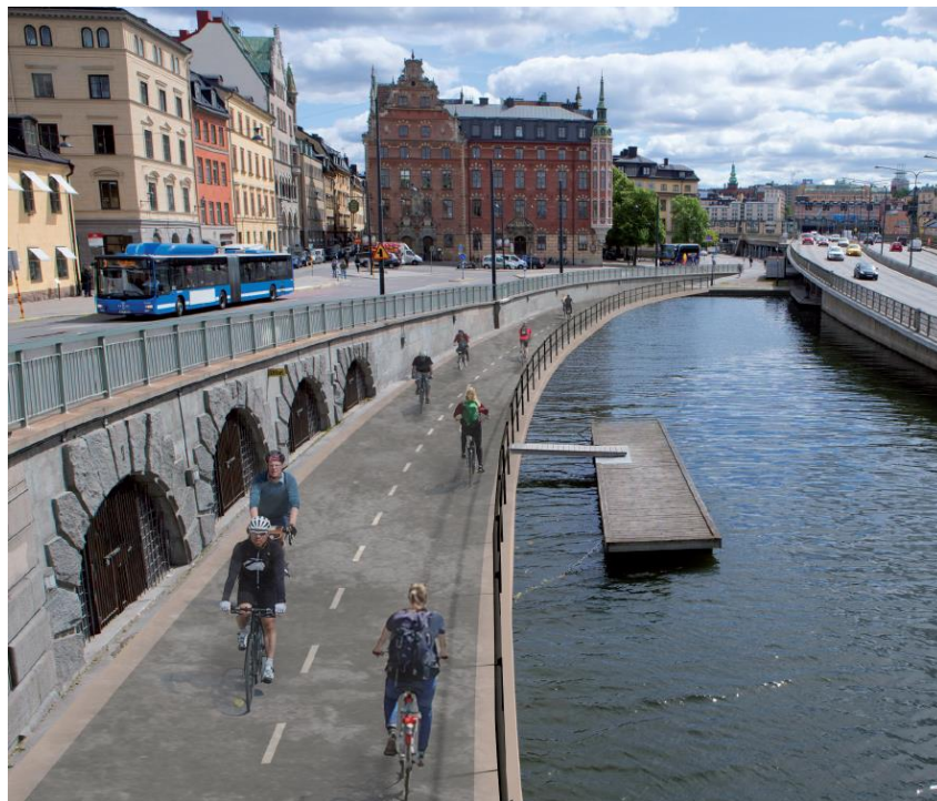
Figur 10. Fotomontage över breddning med konsol
