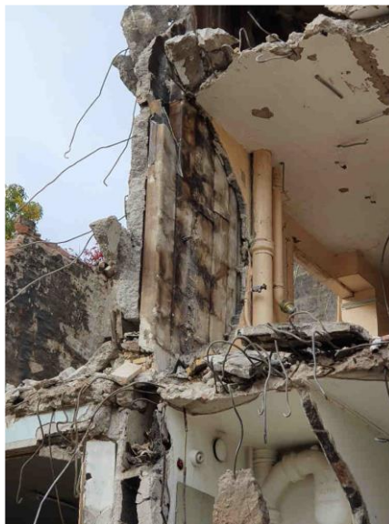
Eternitkanaler i byggnad som håller på att rivas.
