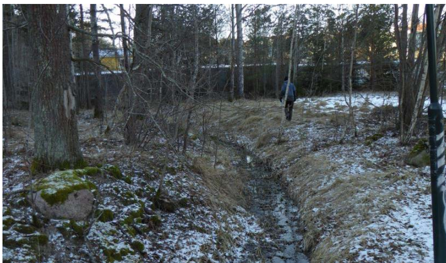
Figur 47. Dagvatten från Kortvingevägen och dess bostäder avleds i ett öppet dike som kan utvidgas till en damm. Foto mot söder. Foto från WRS och Naturvatten (2017), se referenser.
